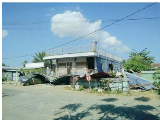
Gambar 5. Salah Satu Gedung Tingkat Tiga Tempat Penitipan Kendaraan Bermotor yang Roboh Akibat Gempabumi, Ratusan Motor dan Beberapa Mobil Terjebak di Dalamnya.
